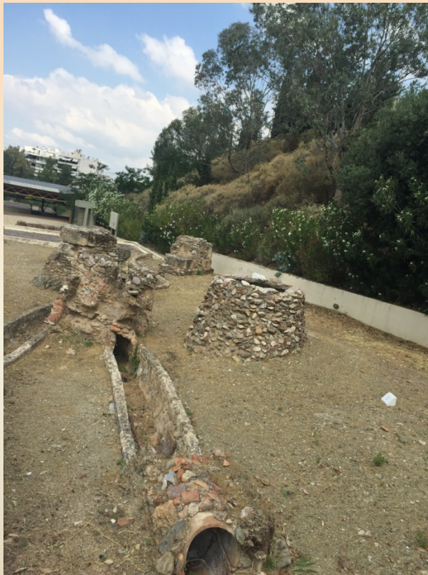
Τμήμα του αγωγού
