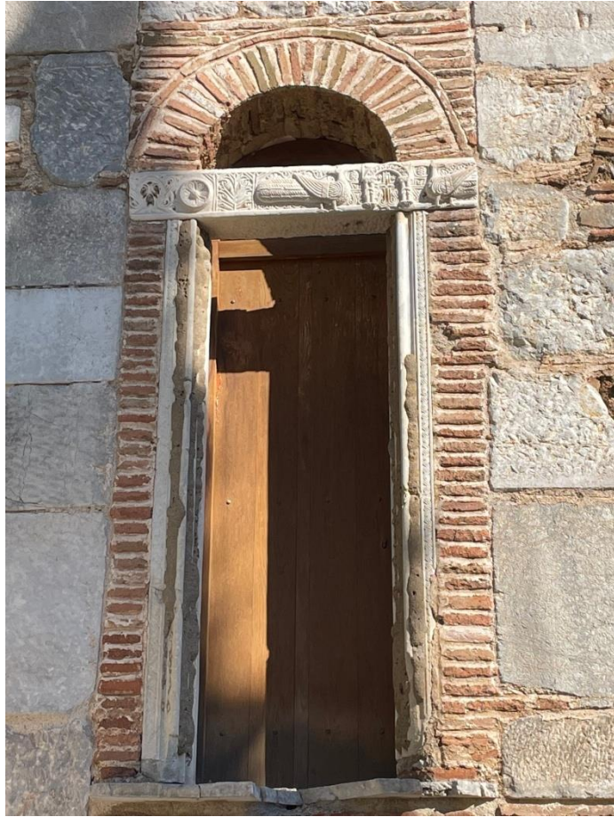
Εικ. 211, Νότια όψη κωδωνοστασίου, προσωπικό αρχείο
