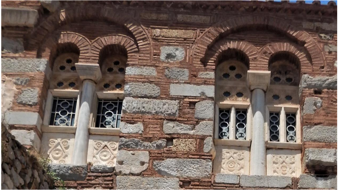
Εικ. 165, Δίλοβα παράθυρα νότιας πλευράς, άνω ζώνης, 4 ο τμήματος, προσωπικό αρχείο
