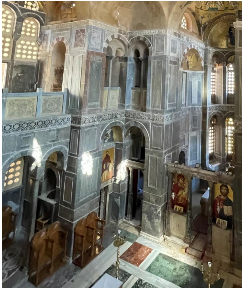
Εικ. 178, Ορθομαρμαρώσεις του Καθολικού, προσωπικό αρχείο
