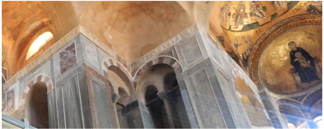
Εικ. 173, Λοξότμητος κοσμήτης στο εσωτερικό του Καθολικού, προσωπικό αρχείο
