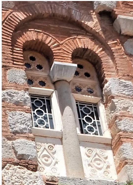
Εικ. 154, Νότια πλευρά 2 ο τμήματος, άνω ζώνη λεπτομέρειες, προσωπικό αρχείο
