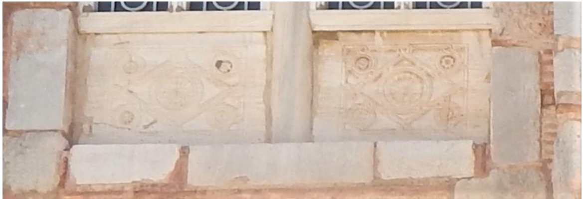
Εικ. 145, Λεπτομέρεια θωρακίων στην άνω ζώνη δυτικής πλευράς του Καθολικού, προσωπικό αρχείο
