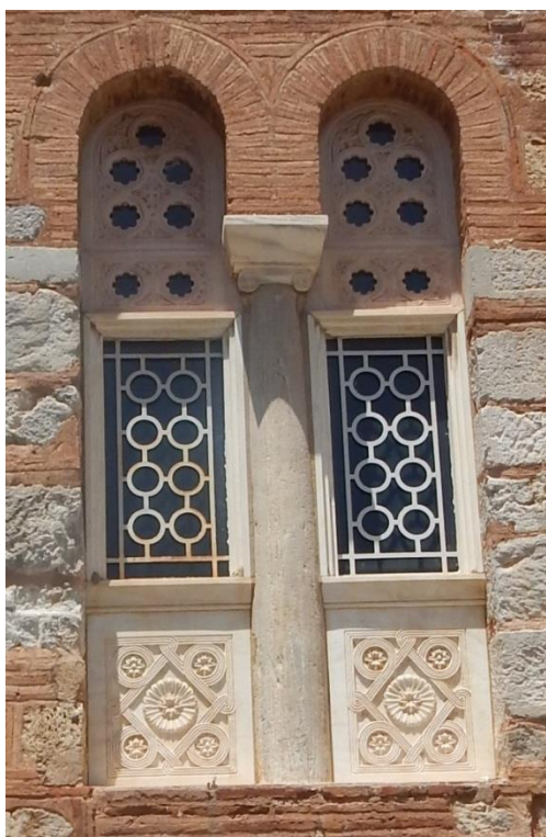
Εικ. 162, Δίλοβο παράθυρο της κάτω ζώνης, 4 ου τμήματος της νότιας πλευράς του Καθολικού, προσωπικό αρχείο
