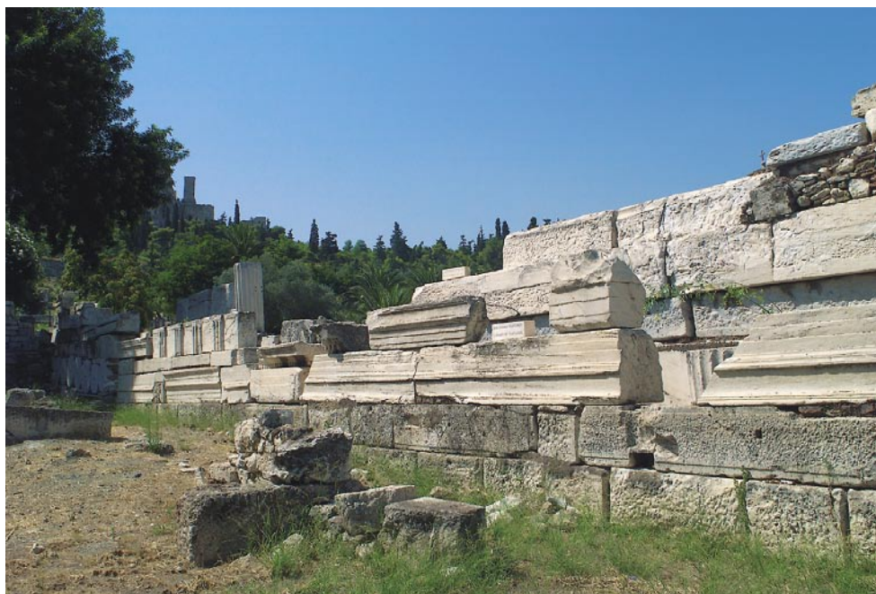
42. Το Υστερορωμαϊκό Τείχος (περ. 280-290 μ.Χ.) με πολλά επαναχρησιμοποιημένα αρχιτεκτονικά μέλη κτιρίων που καταστράφηκαν από τους Έρουλους το 267 μ.Χ.
