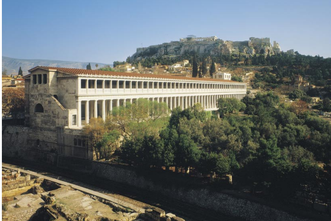
48. Η αναστηλωμένη Στοά του Αττάλου (1953-1956). Άποψη από τα βόρεια-βορειοδυτικά.
