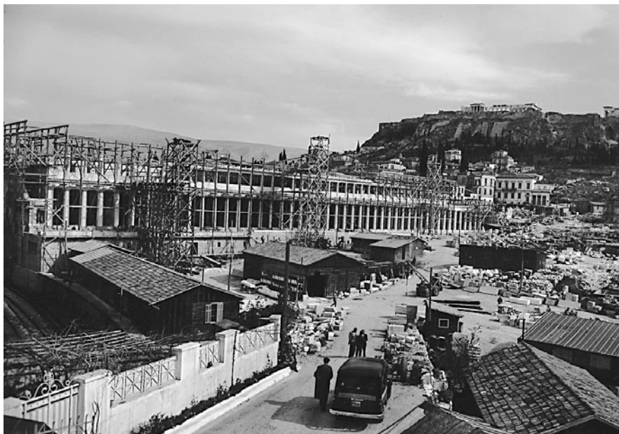
71. Εργασίες αναστήλωσης στη Στοά του Αττάλου το 1956. Άποψη από τα βόρεια.
