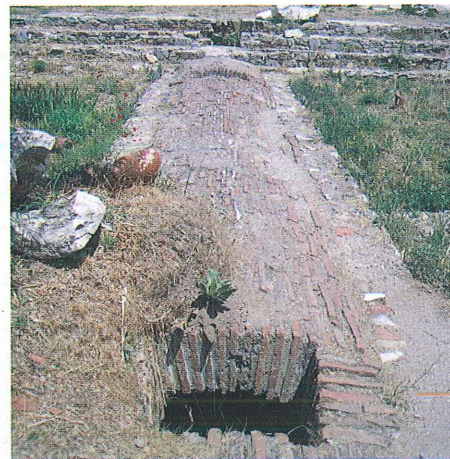
Καμαροσκεπής αγωγός από το δίκτυο ύδρευσης-αποχέτευσης
