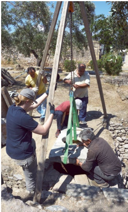
3 Wiederanbringung der Mündungseinfassung mit Hilfe eines Holzstativs | Επανατοποθέτηση του προστομαίου με τη βοήθεια ξύλινου τρίποδα
