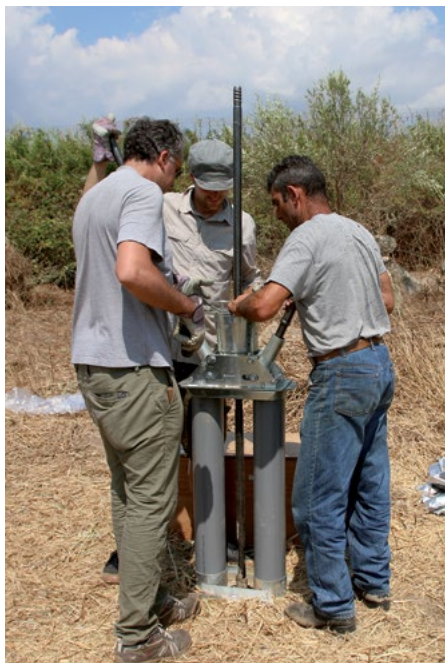
1 Samos, Heraion. Bohrarbeiten nordwestlich des großen Tempels | Σάμος, Ηράϊο. Γεωτρήσεις βορειοδυτικά του μεγάλου ναού
