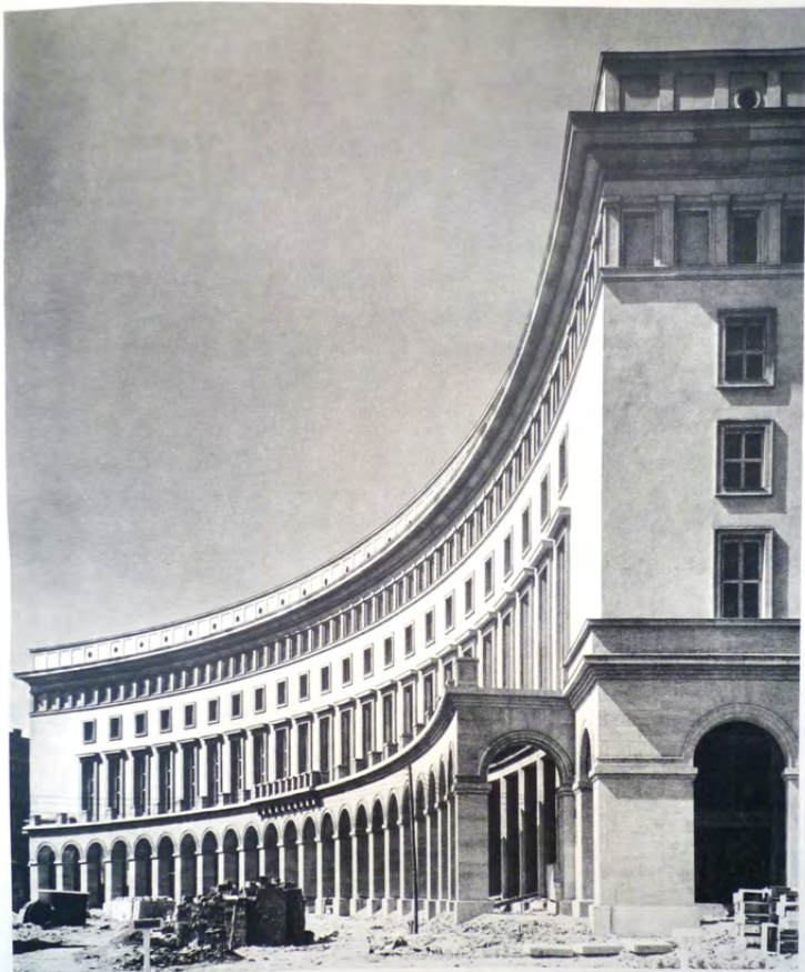
Architekten Hugo Rötcher und Theodor Dierksmeier: Das Fremdenverkehrshaus am Runden Platz in Berlin, im Bau. Aus der Planung des Generalbauinspektors für die Reichshauptstadt — Αρχιτέκτονες Ούγκο Ράιττχαρ και Θεόδωρος Ντίερκσμαιερ: «Ο Όθος του Τουρισμού» στη στρογγύλη πλατεία του Βερολίνου υπό κατασκευήν. Από την μελέτη του γενικού αρχιτεκτονικού επιθεωρητού για την Πρωτεύουσα του Κράτους
