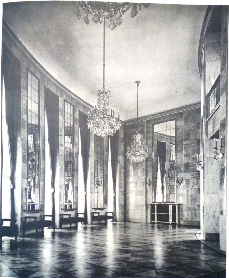
Architekt Paul Baumgarten: Foyer des Theaters in Saarbrücken — Αρχιτέκτων Παύλος Μπούμγκαρτεν: Φουαγιέ του Θεάτρου στὴ Σάρμπρυκεν
