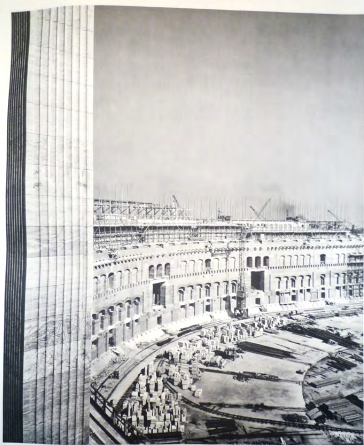
Architekten Ludwig Ruff† und Franz Ruff: Innenraum der Kongreßhalle, im Bau — Αρχιτέκτονες Λουδοβίκος Ρούφ† και Φράντς Ρούφφ: Έσωτερικόν του κτηρίου συνελεύσεων, υπό κατασκευή
