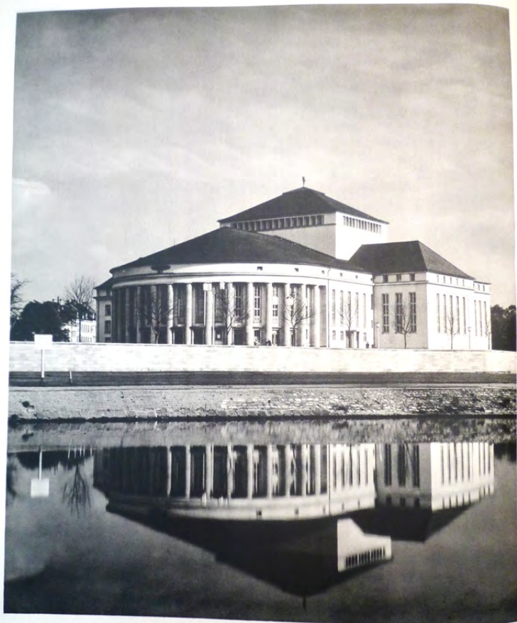
Architekt Paul Baumgarten: Theater in Saarbrücken — Αρχιτέκτον Παύλος Μπάουμγκαρτεν: Θέατρον στὸ Σάαρμπρικεν
