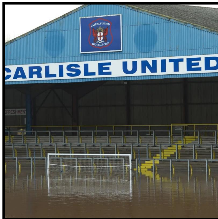
Εικόνα 4: η καταστροφή στο Brunton Park 16
