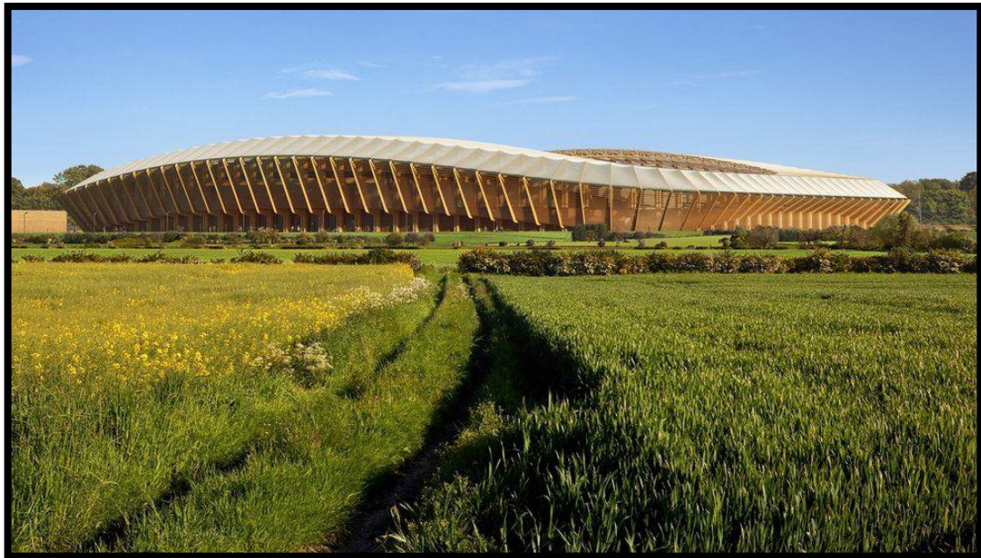
Εικόνα 8: το στάδιο το οποίο στοχεύει να χτίσει η ομάδα. Τα πλάνα είναι να κατασκευαστεί εξολοκλήρου από ξύλο 28
