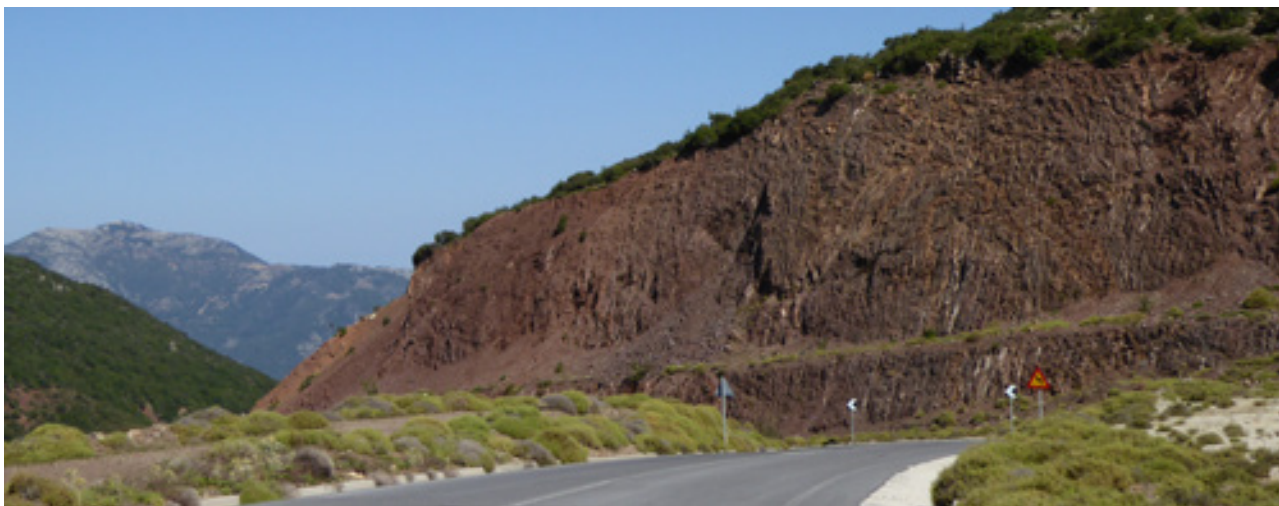
Εικόνα 6.11. Τυπική εικόνα στην ύπαιθρο της ακολουθίας των πηλιτών-ραδιολαριτών της ενότητας της Πίνδου, στην ορεινή περιοχή ανατολικά της Κυπαρισσίας.
