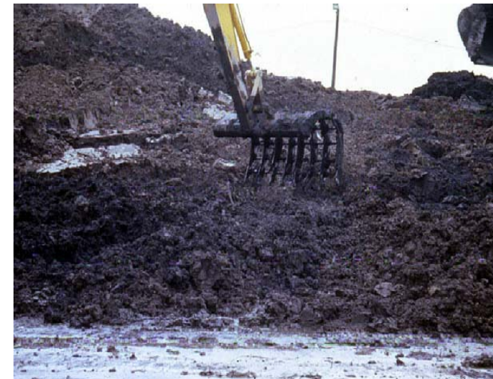
Εικόνα 5-2: Διεργασία και εξοπλισμός in-situ ανάμιξης εδάφους κατά την εφαρμογή της τεχνολογίας της σταθεροποίησης – στερεοποίησης ρυπασμένων εδαφών ( www.cement.ca ).
