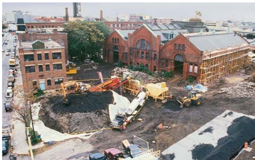
Εικόνα 5-3: On-Site εφαρμογή της τεχνολογίας της σταθεροποίησης – στερεοποίησης ρυπασμένων εδαφών με χρήση τσιμέντου σε περιοχή της Βοστώνης ( www.cement.ca ).
