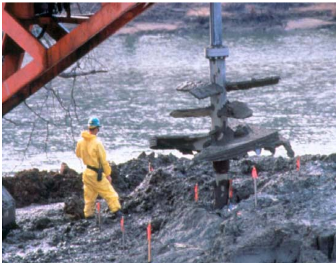
Εικόνα 5-2: Διεργασία και εξοπλισμός in-situ ανάμιξης εδάφους κατά την εφαρμογή της τεχνολογίας της σταθεροποίησης – στερεοποίησης ρυπασμένων εδαφών ( www.cement.ca ).
