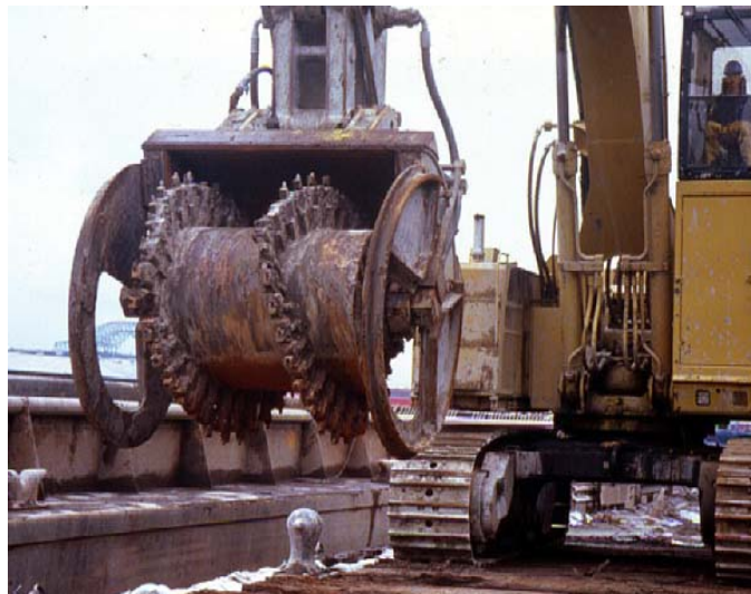
Εικόνα 5-2: Διεργασία και εξοπλισμός in-situ ανάμιξης εδάφους κατά την εφαρμογή της τεχνολογίας της σταθεροποίησης – στερεοποίησης ρυπασμένων εδαφών ( www.cement.ca ).
