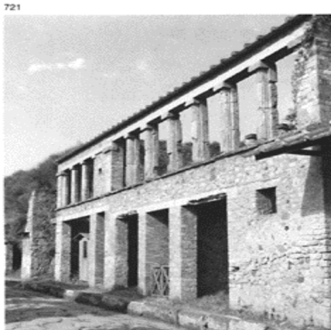
721 First floor loggia with colonnade on the via dell'Abbondanza (IX, 12, 2).
