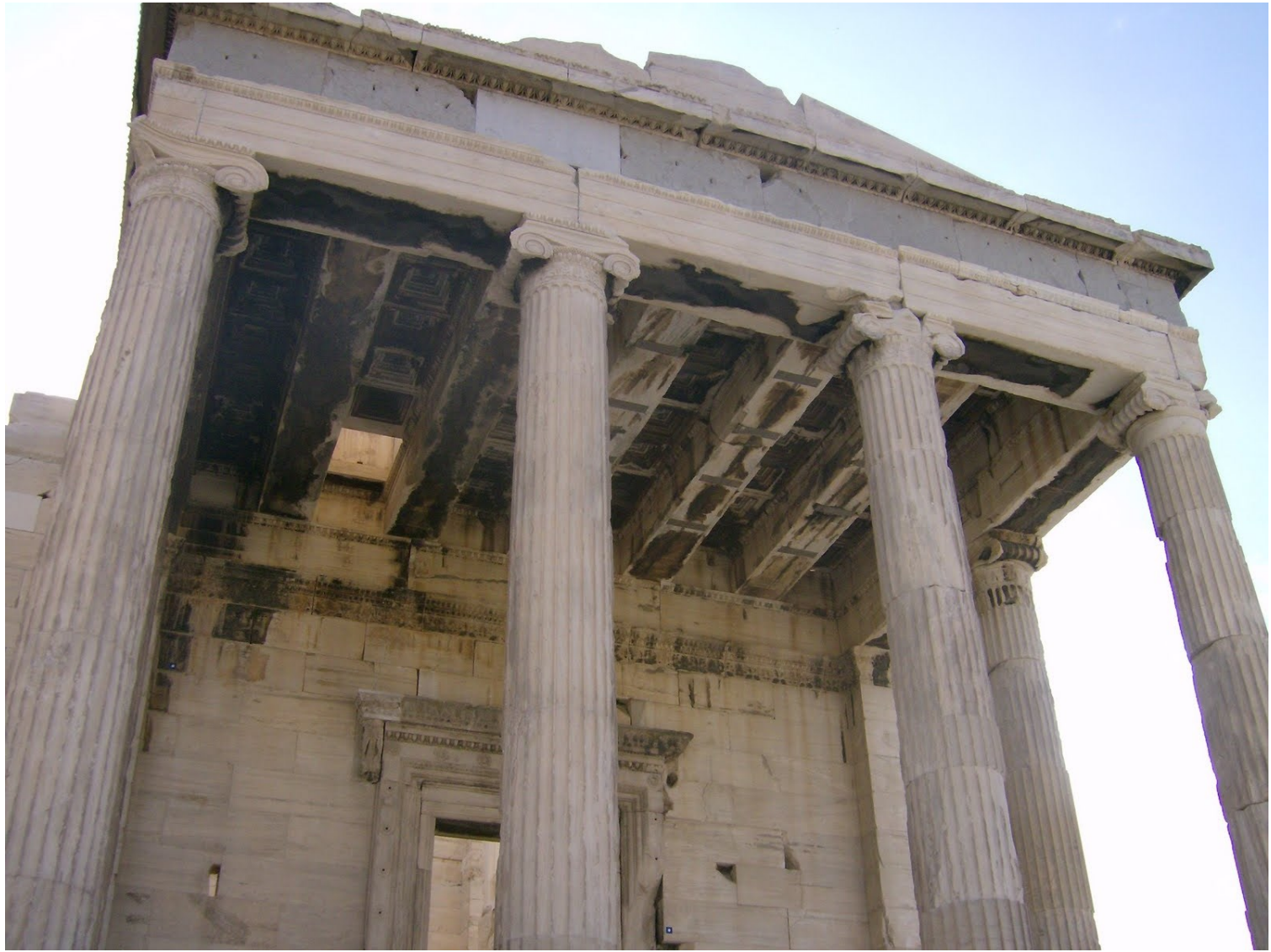
Η οροφή της βόρειας πρόστασης όπως σώζεται σήμερα.
