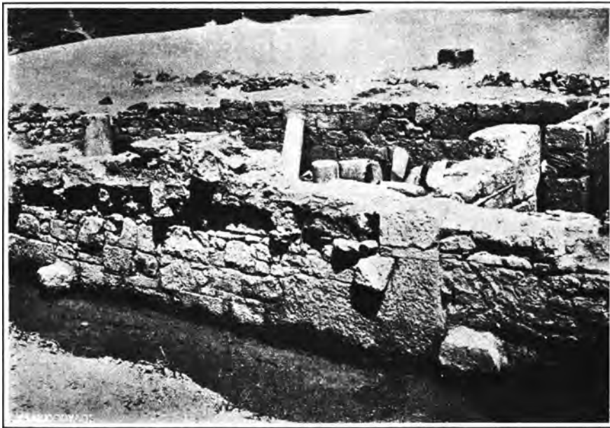
Εἰκ. 11. Γωνία νοτίας πλευρᾶς σηκοῦ. Δεξιὰ πρὸ τῆς γωνίας προσθήκη ὑστερωτέρου κτίσματος.
