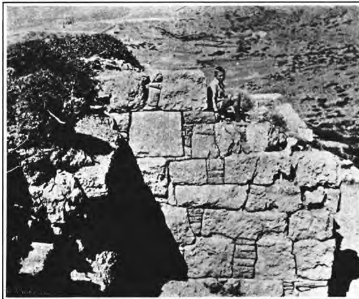
Εἰκ. 45. Τοῖχος πύργου τοῦ φρουρίου Σουνίου.
