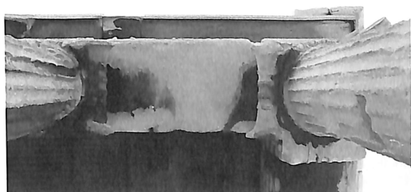
Abb. 2. Nike-Tempel. Wirkung der Verlagerung der Normalvolute. Einseitige Verbreiterung des Eckkapitells
