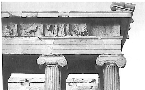
Abb. 1. Nike-Tempel. Wirkung der Verlagerung der Normalvolute. Einseitige Verbreiterung des Eckkapitells
