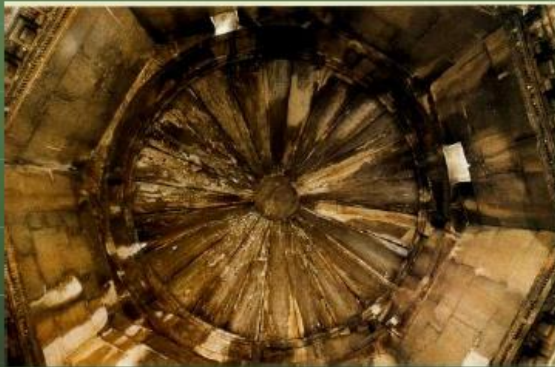
Εσωτερική όψη της στέγης
