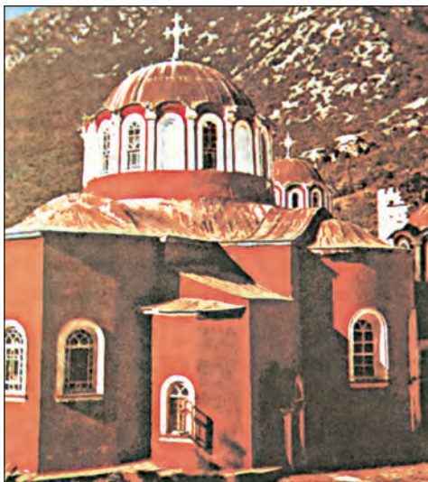
Το Καθολικό της μονής Μεγίστης Λαύρας, Άγιον Όρος, 10ος αι. Αθωνίτικος τύπος του «σταυροειδούς εγγεγραμμένου».
