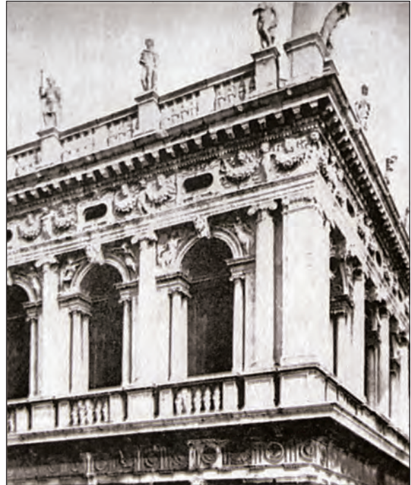
Η Παλαιά Βιβλιοθήκη της Βενετίας, έργο του Γιάκοπο Σανσαβίνο, 1536, όπου διακρίνονται σαφώς όλα τα βασικά στοιχεία του Αναγεννησιακού ρυθμού: κίονες, κιονόκρανα, πεσσοί, θριγκοί, ζωφόρος.
