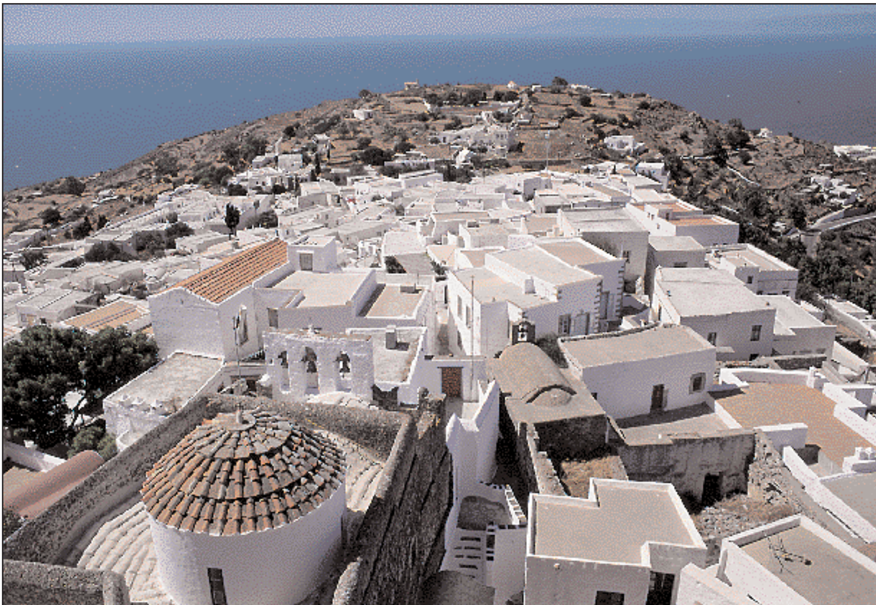
Τα δώματα. Μονοσήμαντη κατασκευαστική μέθοδος για τη συλλογή των νερών της βροχής με κατάληξη τη στέρνα.
