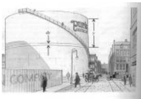
Μία κυλινδρική μεταλλική δεξαμενή ύψους 27.4m και διαμέτρου 27.4m, χρησιμοποιείται για την αποθήκευση μελάσας. Η μελάσα έχει πυκνότητα  $1600 \text{ kg/m}^3$ . Αν η δεξαμενή είναι πλήρης, πόση είναι η συνολική προς τα έξω δύναμη που ασκεί η μελάσα στην κυλινδρική επιφάνεια; Δίδεται ότι  $g=9.8\text{m/s}^2$ .
