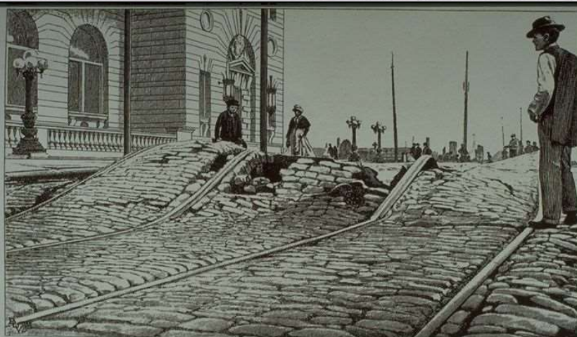
TROTTOIR, ALLÉE DE L'HÔTEL DES POSTES DE SAN-FRANCISCO, MONTRANT UNE VUE DÉFORMÉE VISIBLE DU TREMBLEMENT DE TERRE DU 18 AVRIL 1906 (d'après SCHWABER, Ingénieur en chef de la Spring Valley Water Company) (The Water Supply of San Francisco, before, during, and after the Earthquake of April 18 th 1906, and the subsequent conflagration, San Francisco, July 22 nd , 1906).
