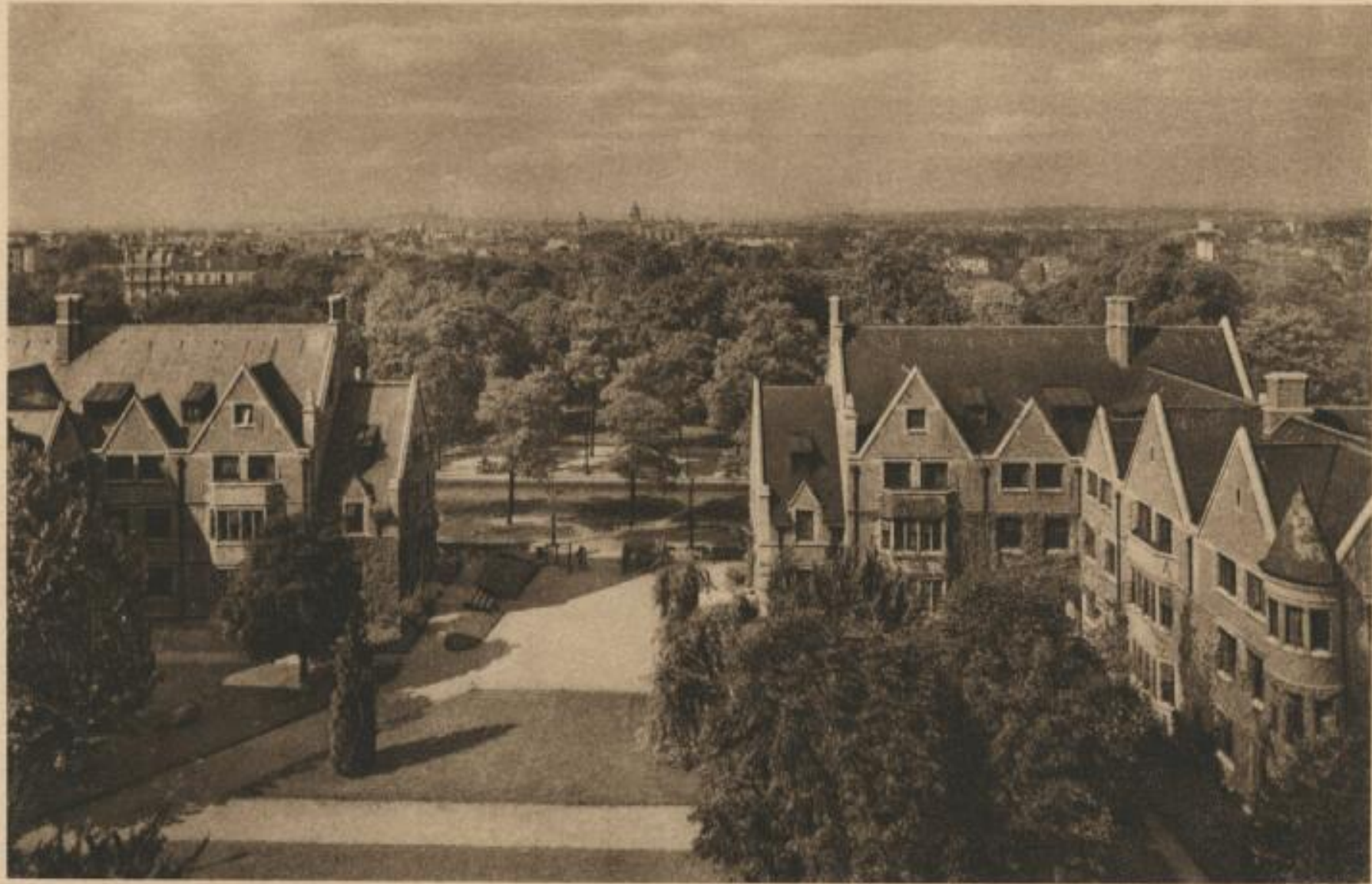
16. - Fondation E. et L. Deutsch de la Meurthe. Vue prise de la Tour, vers Paris
