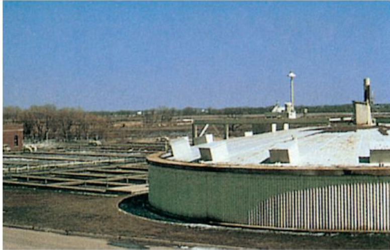
Εικόνα 21.15 Δευτεροβάθμια αναερόβια επεξεργασία υγρών αποβλήτων. (α) Αναερόβιος χωνευτήρας ιλύος. Παρουσιάζεται μόνον το επάνω μέρος της δεξαμενής· τα υπόλοιπα τμήματα είναι υπόγεια. (β) Εσωτερική λειτουργία ενός χωνευτήρα ιλύος. (γ) Οι κύριες μικροβιακές δράσεις κατά την αναερόβια χώνευση της ιλύος. Τα κύρια προϊόντα της αναερόβιας βιοαποικοδόμησης είναι το μεθάνιο ( CH_4 ) και το διοξείδιο του άνθρακα ( CO_2 ).
