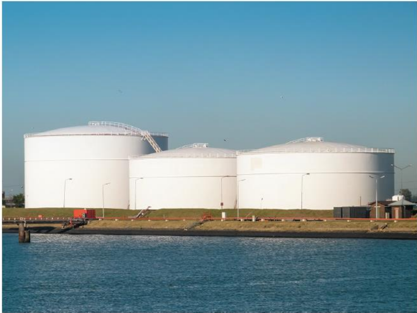
Εικόνα 21.9 Μεγάλες δεξαμενές αποθήκευσης πετρελαϊκών προϊόντων. Οι δεξαμενές αποθήκευσης καυσίμων συνήθως υποστηρίζουν τη μικροβιακή ανάπτυξη στις διεπιφάνειες πετρελαίου - νερού.
