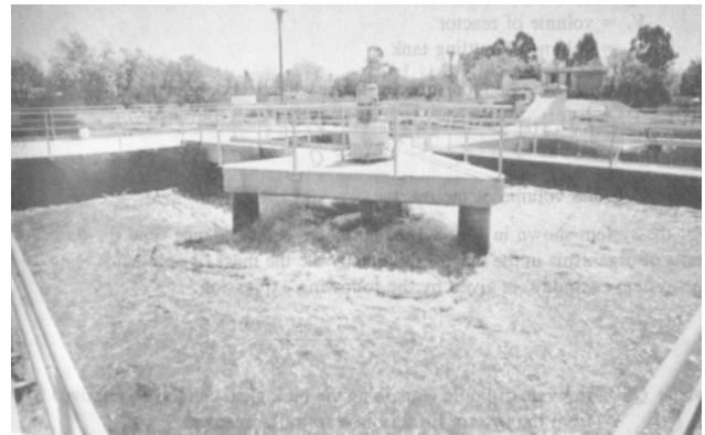
Εικόνα 5. Δεξαμενή αερισμού κατά τη δευτερογενή επεξεργασία υγρών αποβλήτων.
