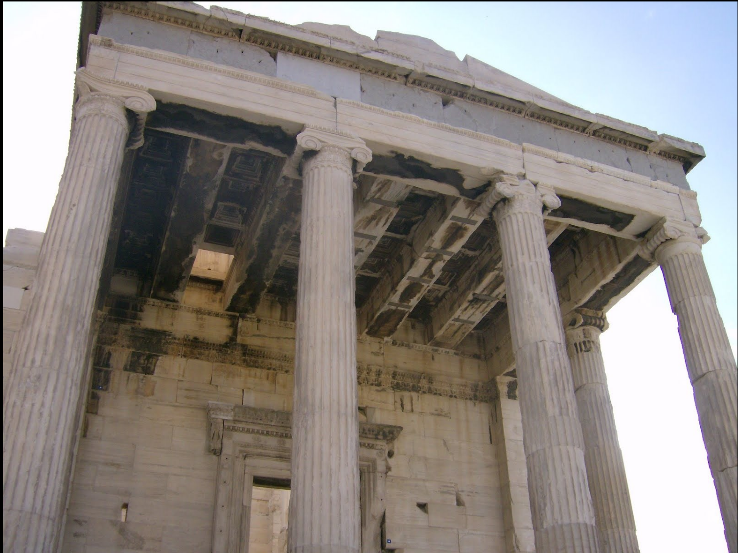
οροφή της βόρειας πρόστασης όπως σώζεται σήμερα
