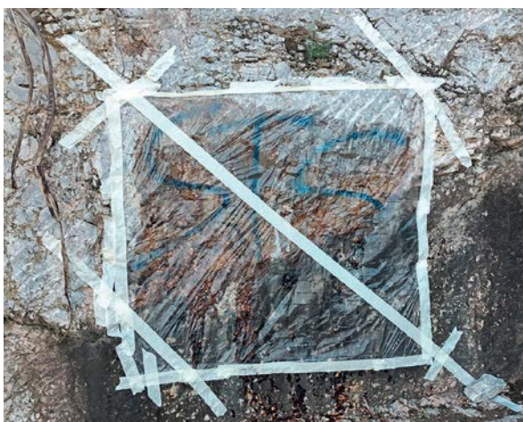
Εικ.3: Δοκιμή καθαρισμού με ακετόνη
