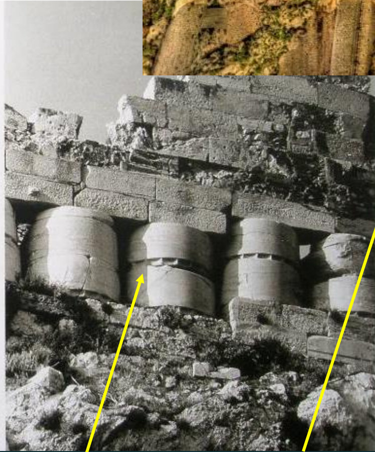
Σπόνδυλοι και τμήματα του θριγκού του Προπαρθενώνος που εντοιχίστηκαν στο βόρειο τοίχο της Ακρόπολης από τον Θεμιστοκλή το 479 π.Χ.
